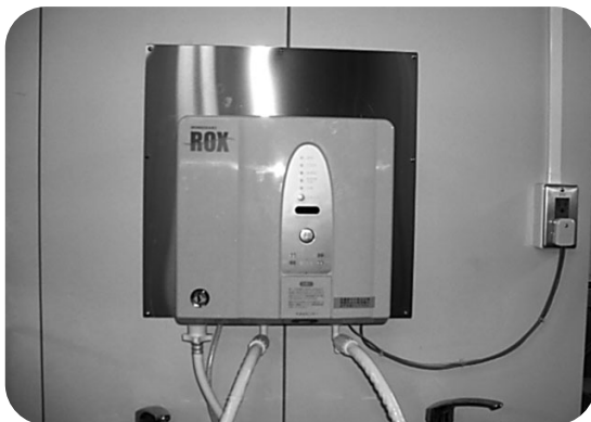
電解水生成装置
